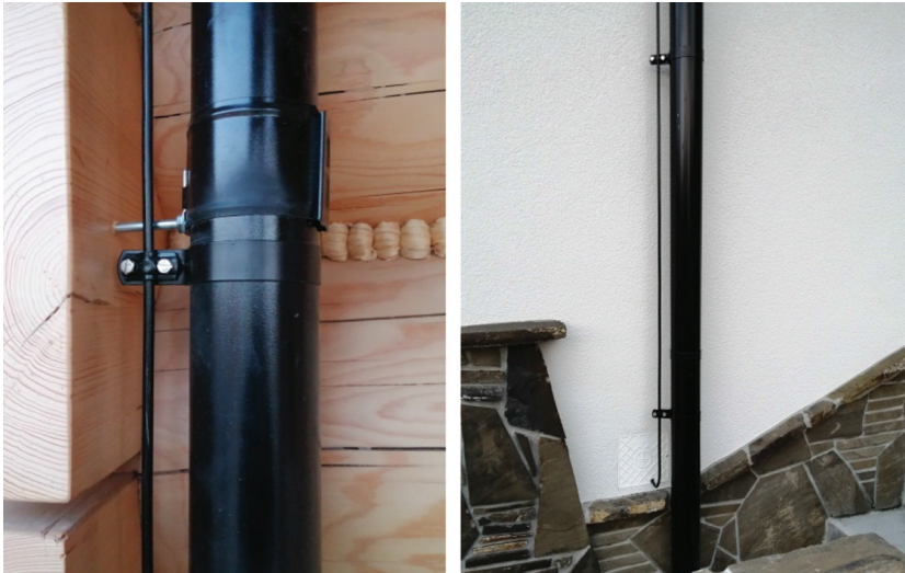
Rys. 7. Przewód odprowadzający na opaskach dopasowany do systemu rynnowego.
