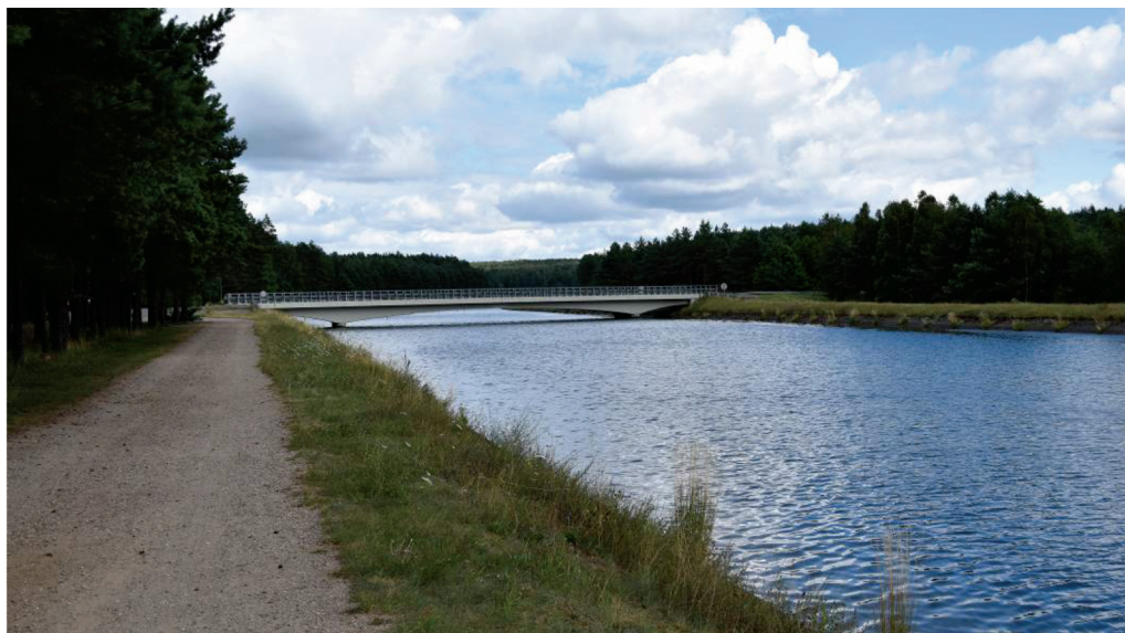
Fot. 1. Kanał derywacyjny górnej wody, most na drodze nr 205.
