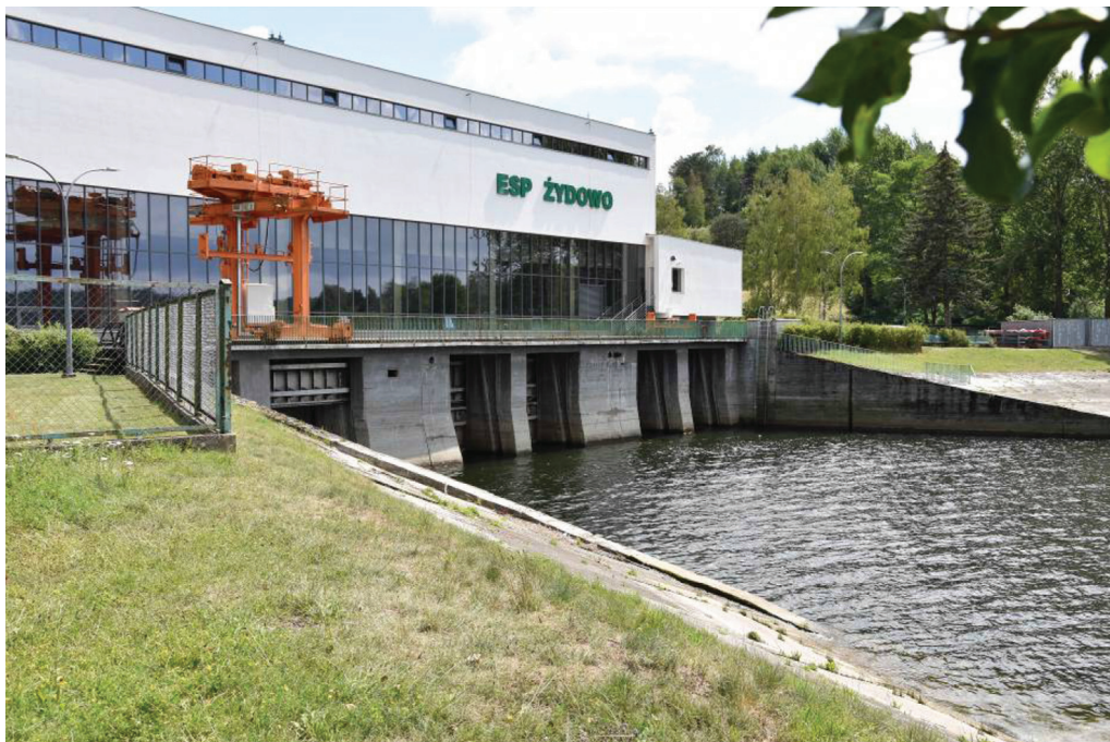
Fot. 5. Budynek elektrowni z wyływem dolnej wody.
