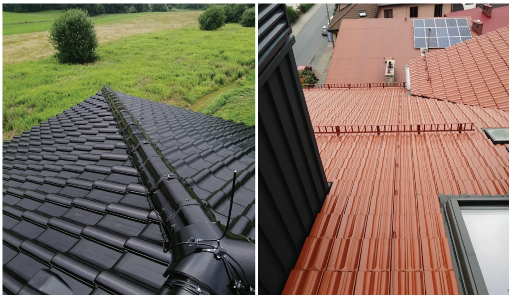
Rys. 5. Siatka zwodów w kolorze pokrycia dachowego.
