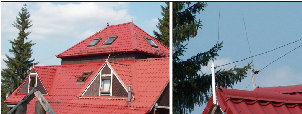
Rys.2. Przykład wykonania zwodów nad dachem krytym blachą.
