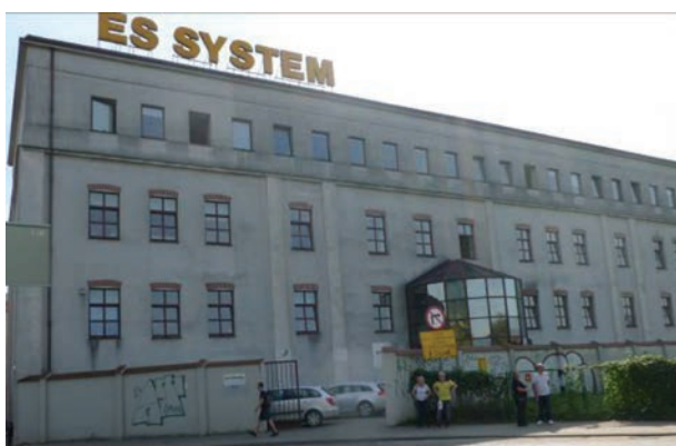
Fot. 24. Siedziba firmy ES-SYSTEM przy ul. Przemysłowej 2 [9].
