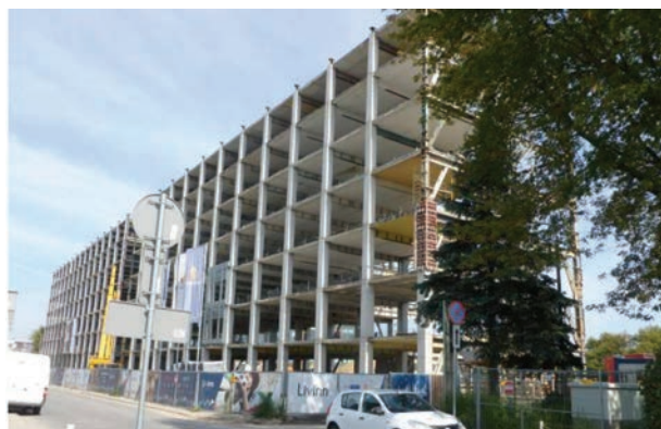
Fot. 21. Dawny budynek Wydziału Potencjometrów aktualnie przebudowywany na akademik [9].
