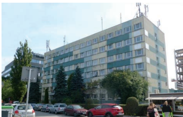
Fot. 22. Budynek OBR MHiR – stan aktualny [9].
