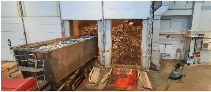
Fot. 6. Rozładunek odpadów do żelbetowego zbiornika na śmieci (bunkra).
