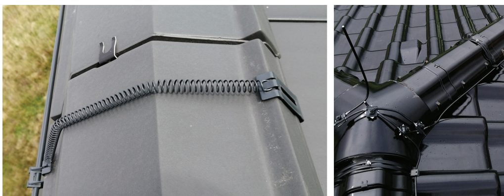
Fot. 4. Zaciski i wsporniki w kolorach zgodnych z kolorami drutów (oryginalne kolor elementów to kolor srebrny).
