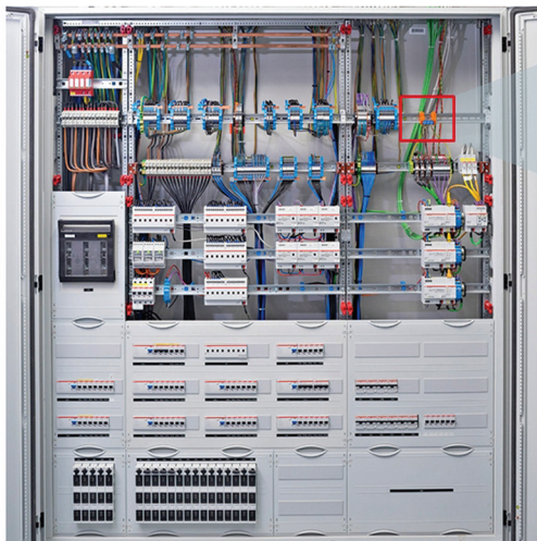
Rys. 7. Ochrona przepięciowa instalacji wideodomofonu z magistralą KNX; 3 – ogranicznik przepięć do ochrony urządzeń pracujących w magistrali KNX. Przykład zabudowy ogranicznika w szafie zasilającej sterującej budynku biurowego.
