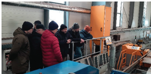
Fot. 10. Hala tokarki podtorowej
