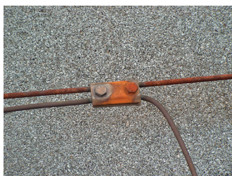
Fot. 2. Skorodowane elementy urządzenia piorunochronnego.
