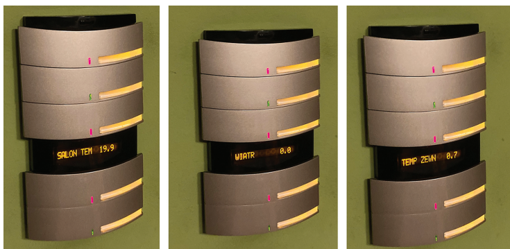
Rys. 2. Informacja o temperaturze i wietrze pokazana na wyświetlaczu zadajnika.
