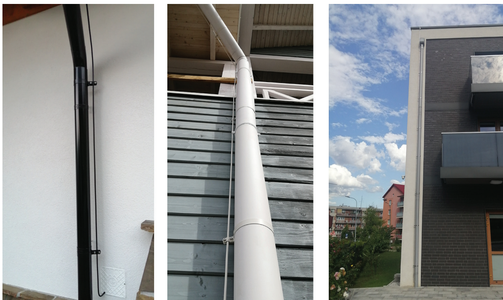
Fot. 6. Prowadzenie przewodu odprowadzającego po rurze spustowej.
