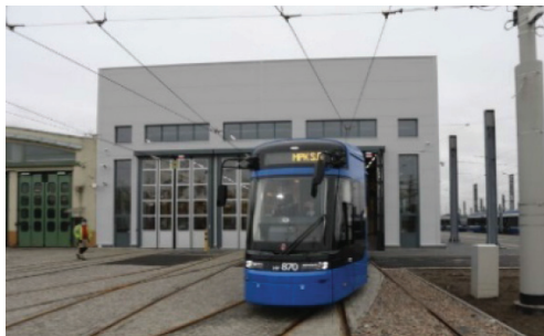
Fot. 11. Nowa hala SO4.
