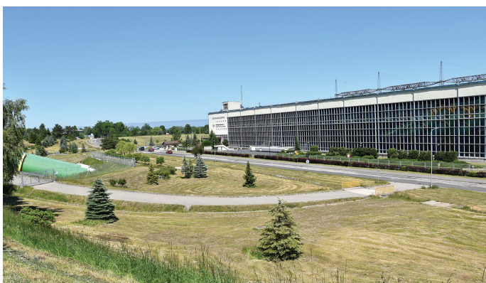
Budynek elektrowni od frontu, z lewej strony widoczna zielona rura górnej wody
