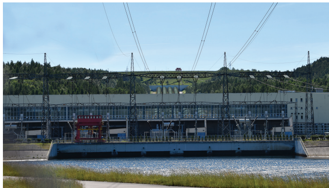
Budynek elektrowni szczytowo-pompowej, widok od strony jeziora
