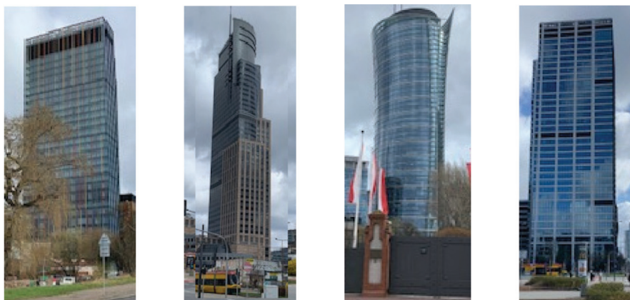
Rys. 1. Przykładowe budynki wysokie Warszawy.
