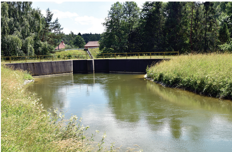
Fot. 5. Wyptyw wody z syfonu; początek drugiego odcinka otwartego kanału derywacyjnego
