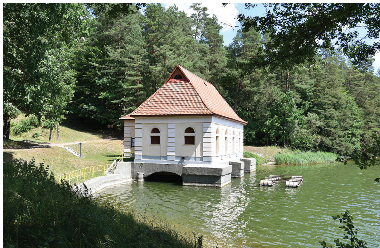
Fot. 1. Pierwszy Zamek Wodny nad Jeziorem Głębokim; pobór wody z jeziora
