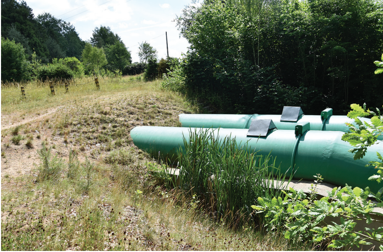
Fot. 7. Rury górnej wody, wychodzące spod ziemi na szczycie wzgórza nad budynkiem elektrowni
