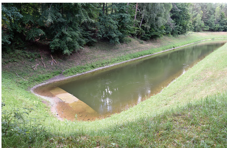
Fot. 2. Wyptyw wody z betonowej sztolni; początek pierwszego odcinka otwartego kanału derywacyjnego
