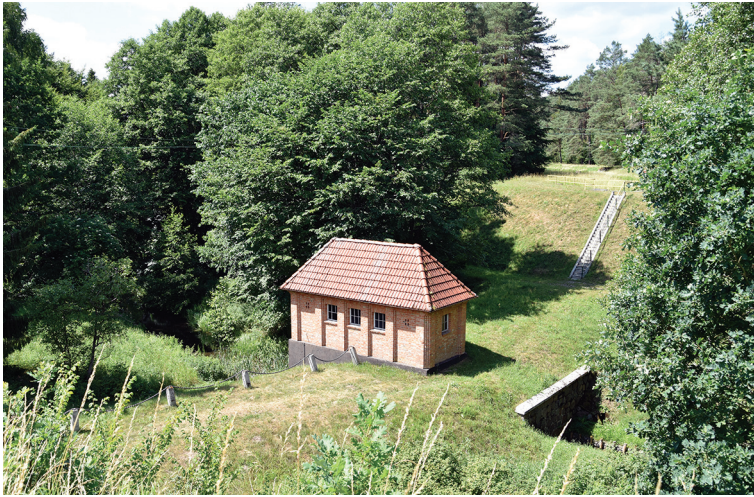
Fot. 4. Trzeci Zamek Wodny na syfonie; skrzyżowanie Słupi z Huczkiem
