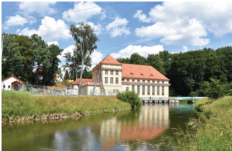
Fot. 10. Budynek elektrowni od strony wypływu dolnej wody spod turbin; z prawej strony widoczne zielone rury górnej wody
