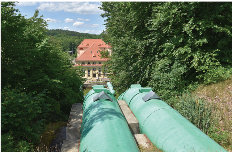
Fot. 8. Rury górnej wody, schodzące po zboczu wzgórza w dół ku turbinom
